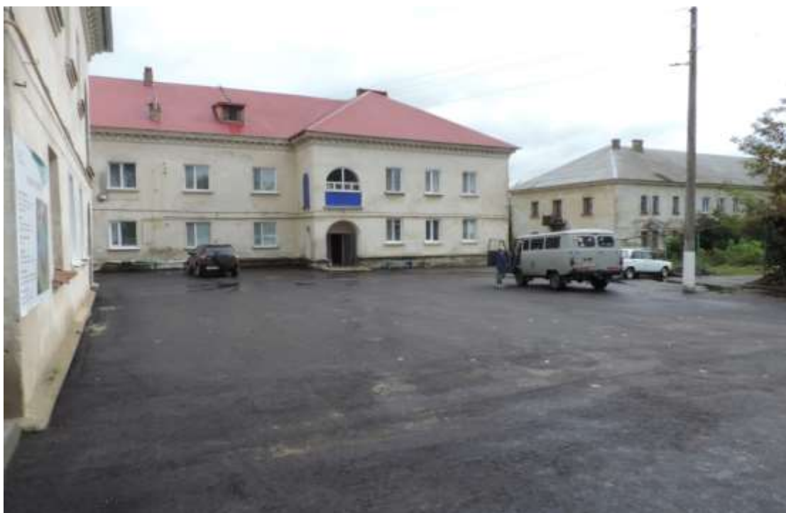
13. Проводился косметический ремонт подъездов многоквартирных домов
