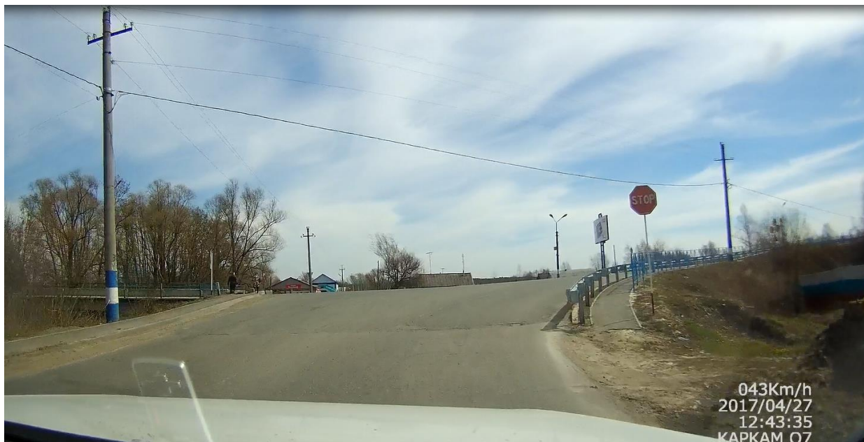
Рисунок 38. Перекресток улиц Шоссейная и Садовая
