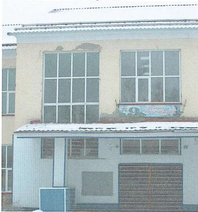
Главный (южный) фасад
