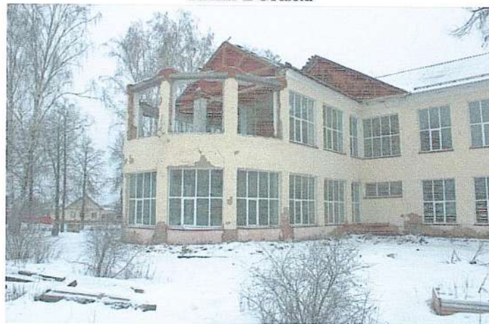
Главный (южный фасад)
